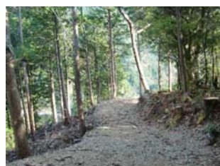
切盛土工による作業道
