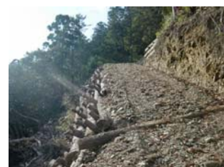
現地材料を利用した路側構造
