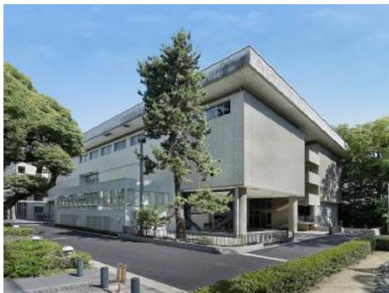
【北側からの外観】
