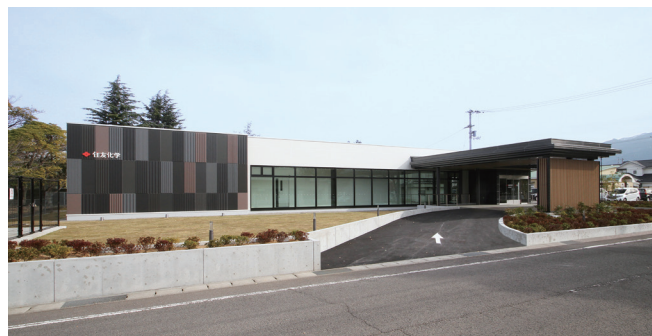
実際の建設物
