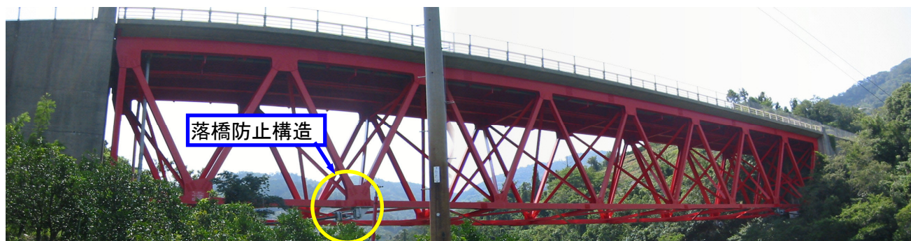
橋桁に設置した落橋防止構造
