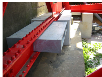
橋桁の受台に設置した変位制限構造
