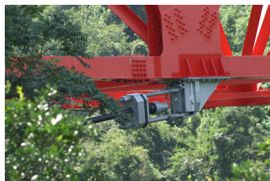
橋桁に設置した落橋防止構造
