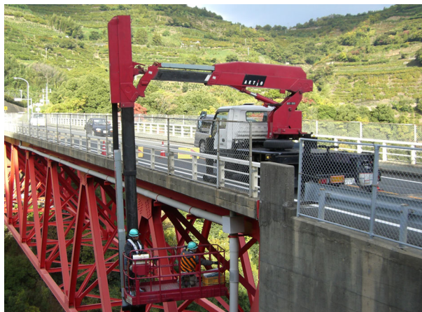
国道 197 号線 保内大橋 上路式トラス鋼橋 橋長 71.4m 幅員 10.3m
