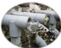
水抜きボーリング排水状況 集中豪雨直後撮影
