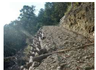
現地材料を利用した路側構造
