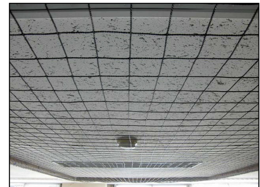
落下防止措置: ネット工法参考例 (協立工業㈱カタログより引用)
