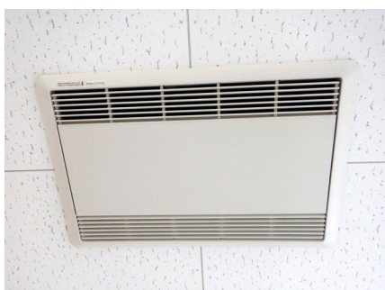
全熱交換機（熱損失の低減）
