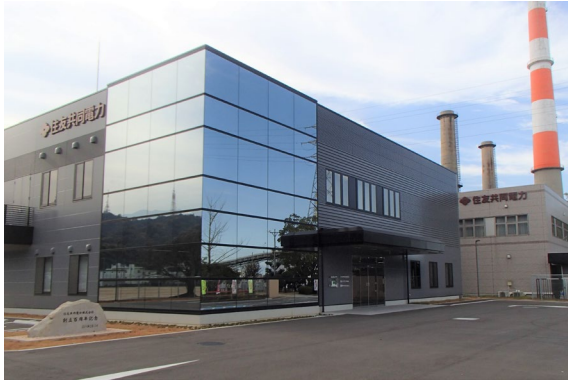
① 南東から見た建屋外観
