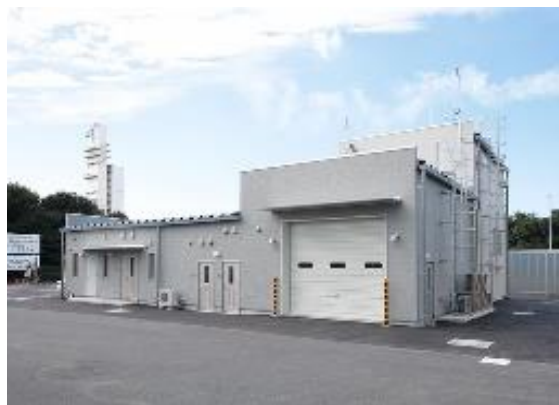
消防車庫側外観
