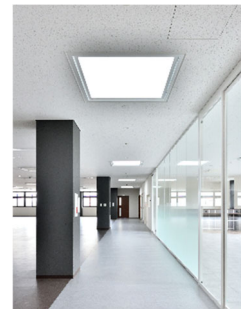
光ダクトによる採光
