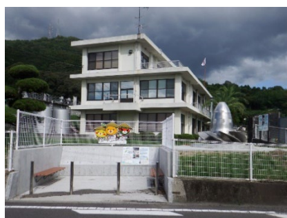
【 旧肱川発電所水車展示：松山発電工水管理事務所内(松山市) 】
