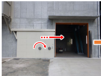
【 ②スライド式防水板：1F機器搬入出用シャッター部 】
