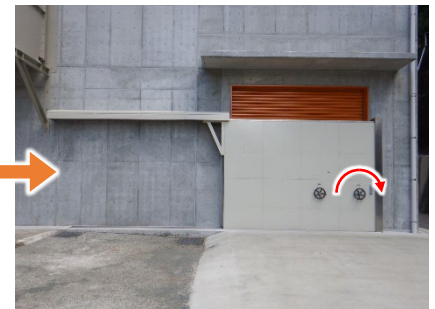
【 ②スライド式防水板：1F機器搬入出用シャッター部 】
