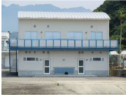
艇庫北側外観
