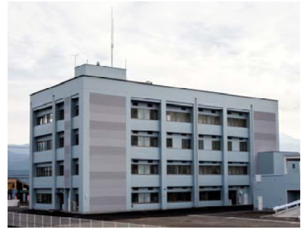
北側からの外観
