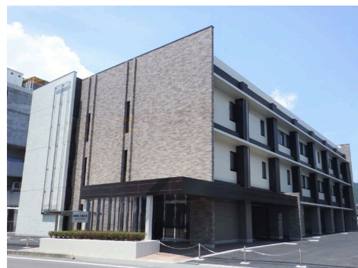
■ 正面からの外観
